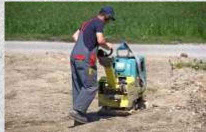
Nach dem Aushub wird der Boden gut verdichtet, zum Beispiel mit einem Handstampfer oder einer Rüttelplatte. Nur ein stabiler Untergrund verhindert späteres Absacken der Steine und somit Stolperfallen in der Fläche.
